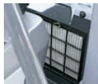
Filtro interno del aire acondicionado
